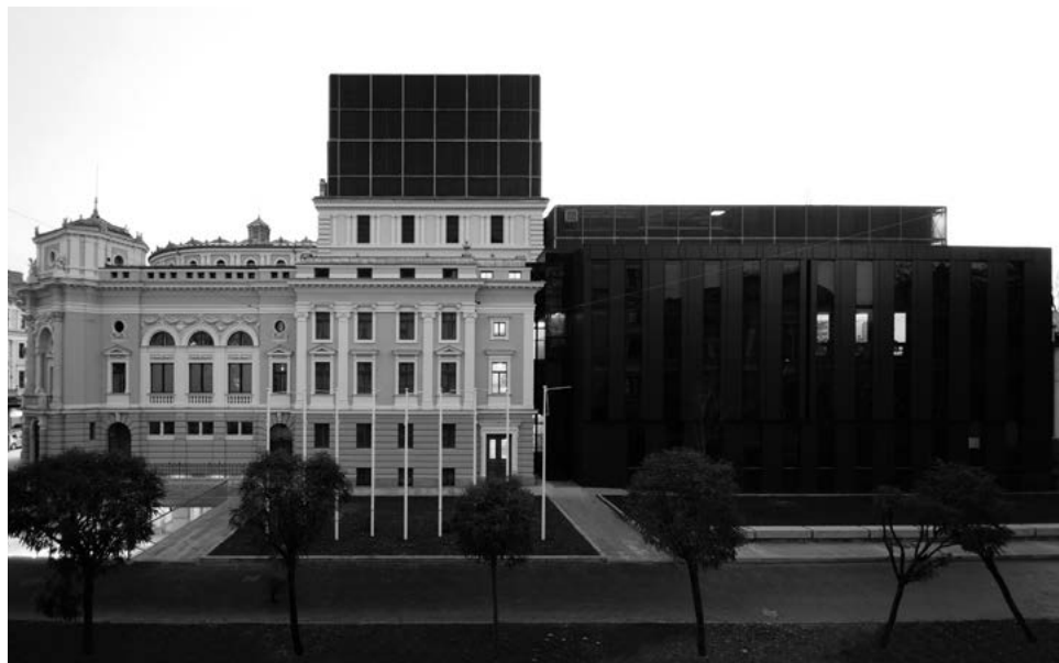
3 | Pogled na severno fasado
